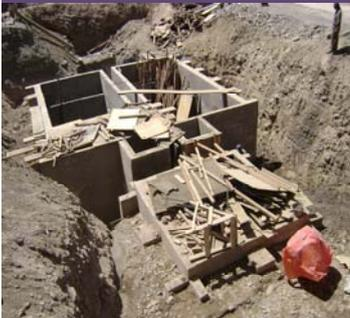
Sistema de filtración y succión en etapa de instalación de accesorios y armado de cámaras de control.
